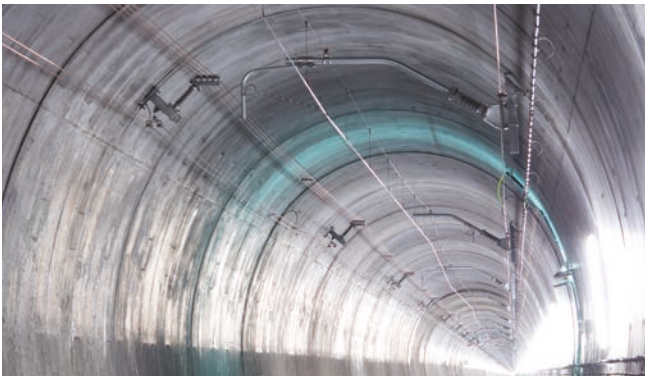
ALPTRANSIT (CH) NEUBAUSTRECKE GOTTHARD- UND CENERI- BASISTUNNEL
